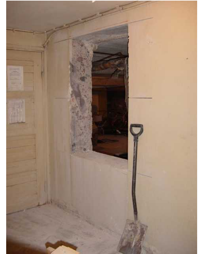
Kuva 13: B-talon porrashuoneesta (kellarikerros) puhkaisu uusi yhteys entiseen koksivarastoon.
