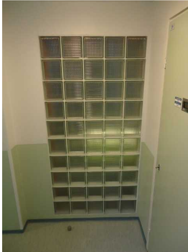
Kuva 17: Huoneiston B20 (B42/43) käytöstä poistu- nut oviaukko.
