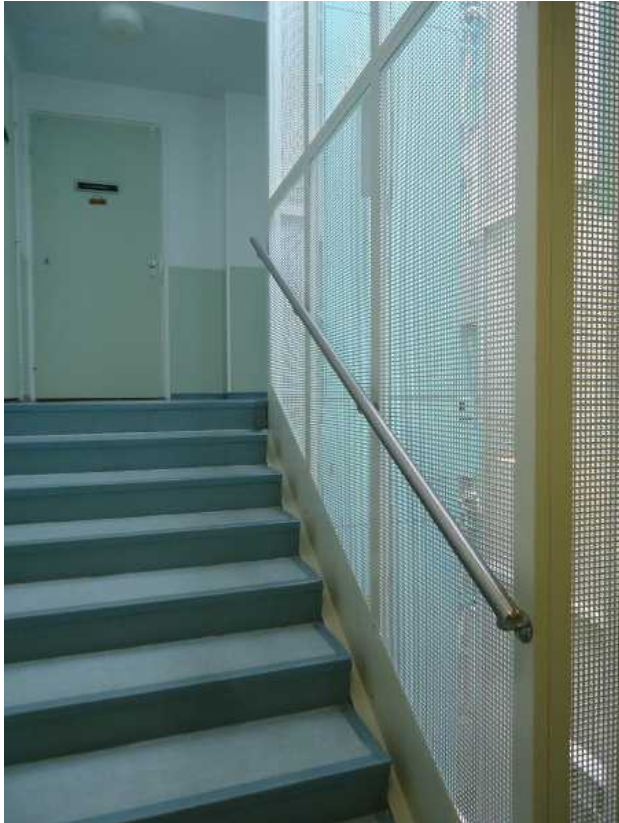
Kuva 15: Hissikuilu, verkkoseinä sekä uusi porraskai- de – alla hissikuilun pintarakenne..
