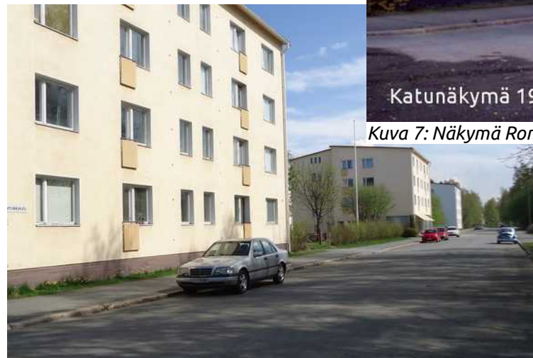
Kuva 8: Julkisivu maalauksen jälkeen
