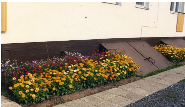
Kuva 2: B -talo, seinusta kunnostamisen jälkeen 1994
