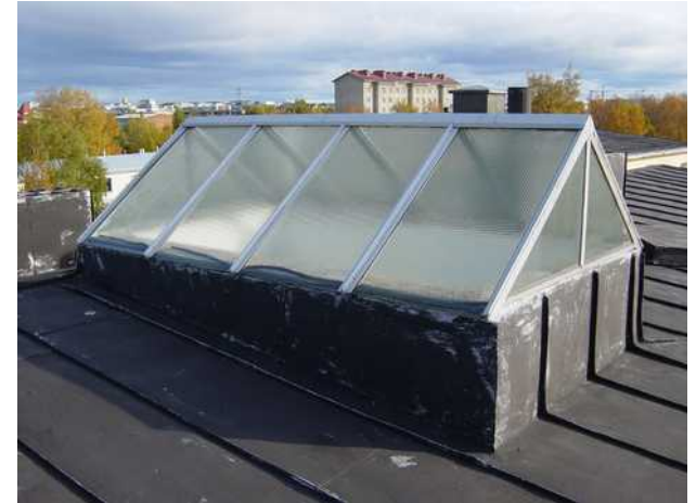
Kuva 18: Porrashuoneen valokuilun päällä oleva kat- toikkuna, todennäköisesti alkuperäinen.
