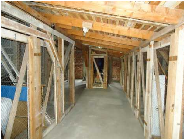
Kuva 21: Ullakkovarastot, ei muutoksia rakentamisen jälkeen.
