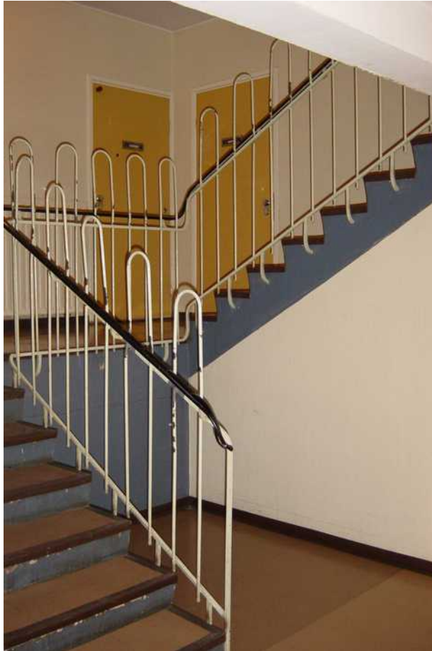
Kuva 14: Porrashuone ennen hissien asentamista.
