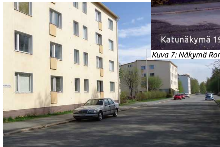
Kuva 8: Julkisivu maalauksen jälkeen
